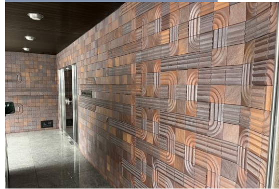
施工前 デザインタイル
