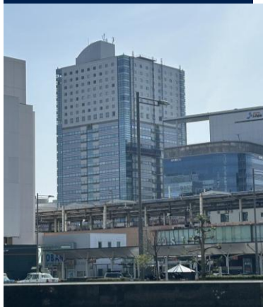
施工後 超高層ビル
