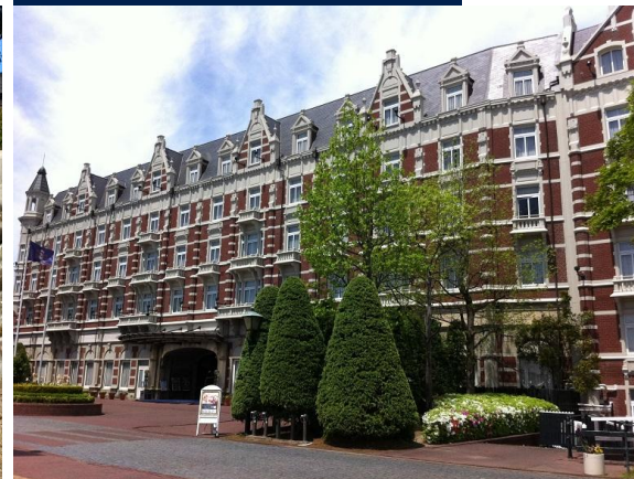
施工後 テーマパーク
