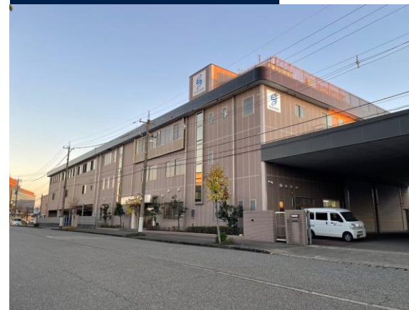
施工後 事務所・倉庫
