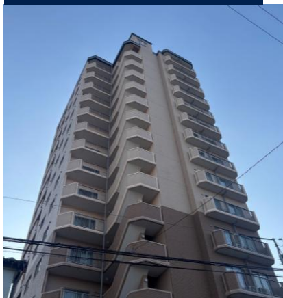
施工後 集合住宅
