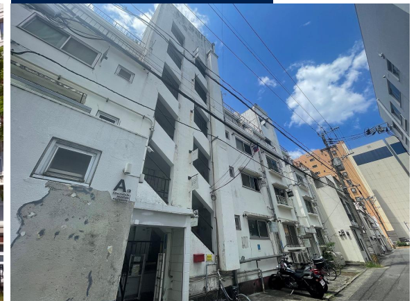
施工後 国有文化財
