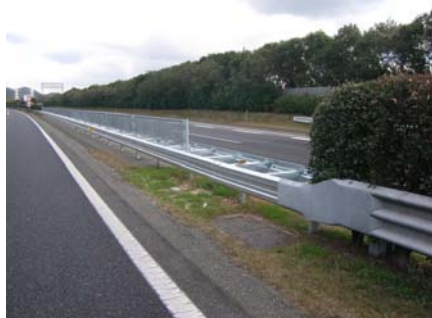
防護柵・標示設置工事
