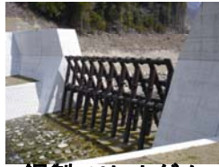
鋼製スリットダム
