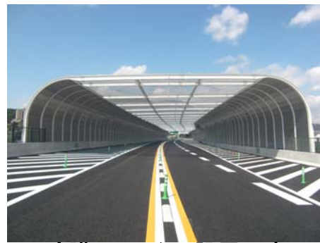
防護シェルター設置工事
