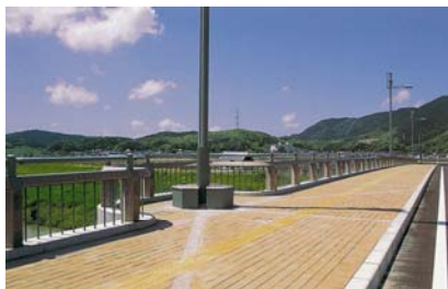
高欄・タイル設置工事
