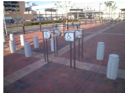
車止め・フェンス設置工事
