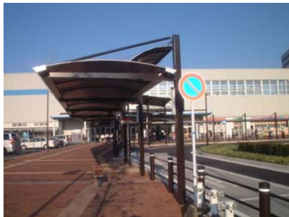
シェルター設置工事
