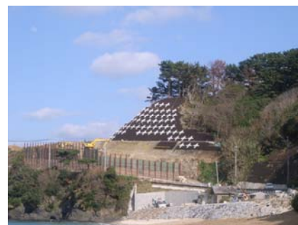
グランドアンカー工法
