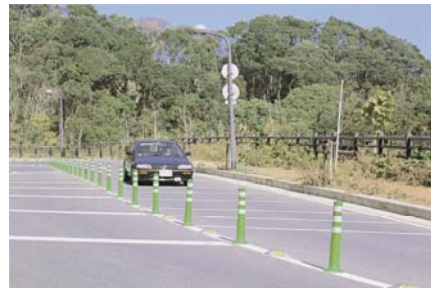
視線誘導標設置工事
