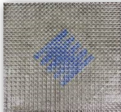
ガラス連続繊維シート貼付け・含浸
