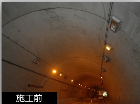
トンネル 剥落防止工事 254㎡ (山口県)
