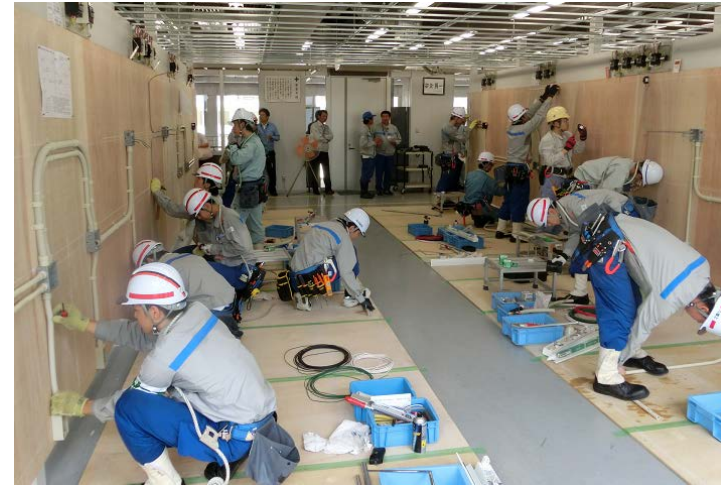
電気配線研修
