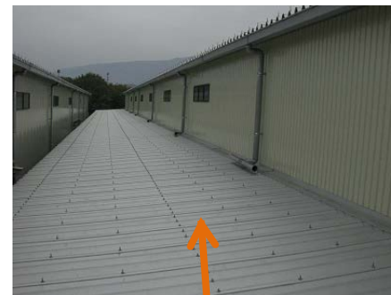
⑤折板（金属屋根材）
