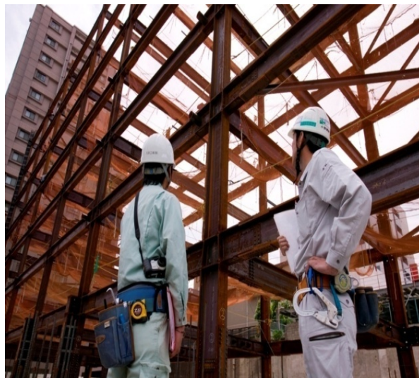
建築工事現場2
