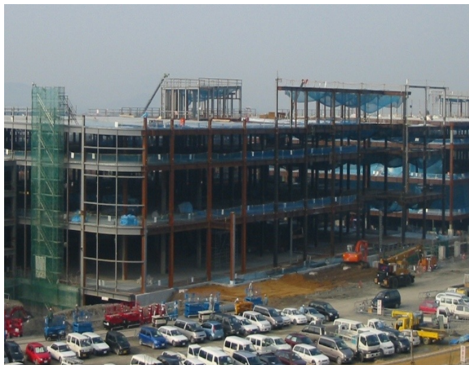
建築工事現場1
