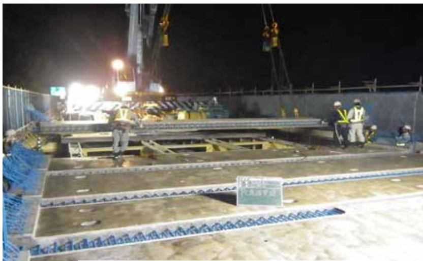
屋嘉第一高架橋(沖縄県) 既存床版を撤去、新たにプレキャストP C床版を設置
