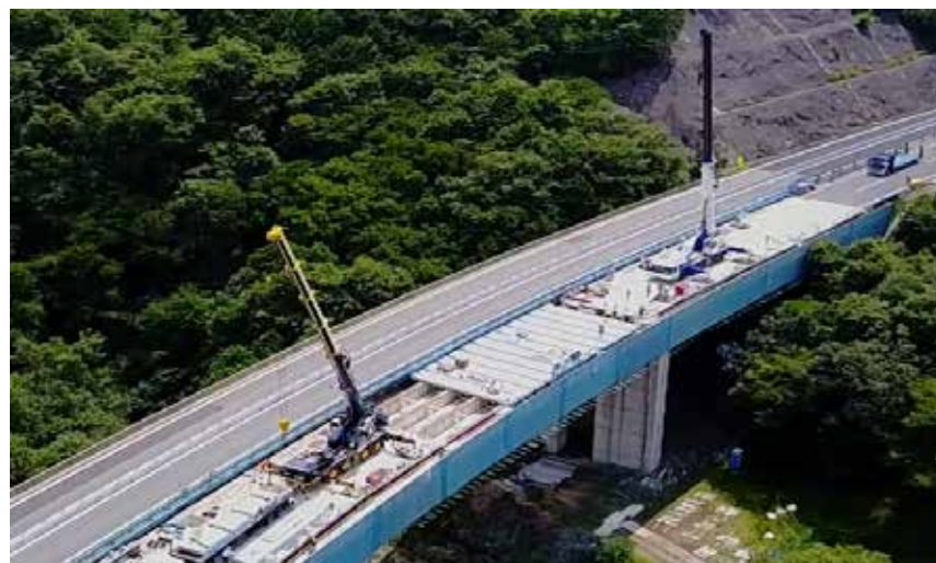
屋嘉第一高架橋(沖縄県) 既存床版を撤去、新たにプレキャストP C床版を設置
