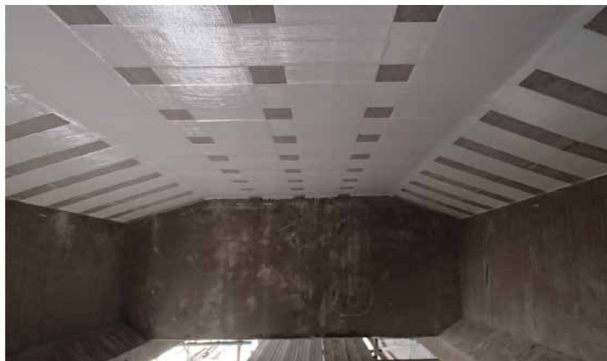
首都高速道路(東京都) 炭素繊維シートによる床版補強
