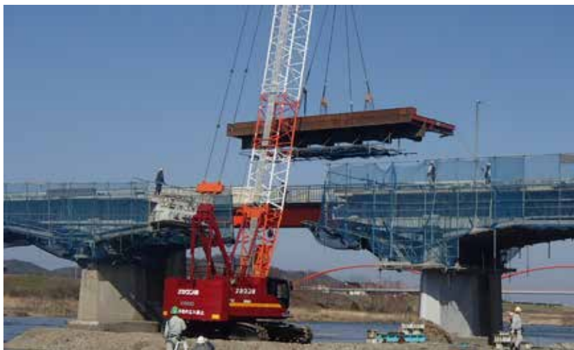
源田橋(鳥取県) 外ケーブルによる桁補強、炭素繊維シートによる床版補強
