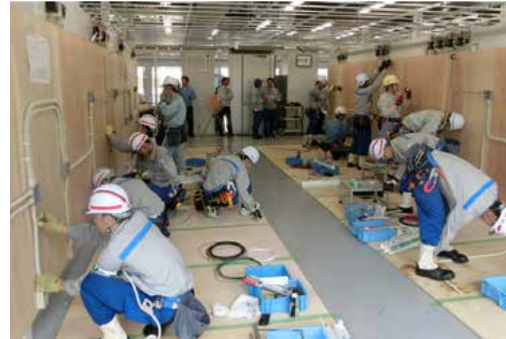
電気配線研修
