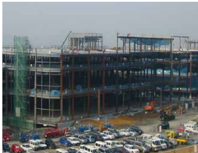
建築工事現場1
