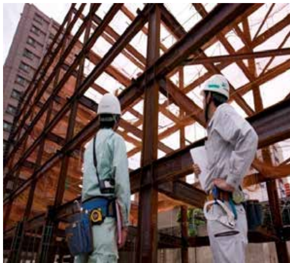
建築工事現場2
