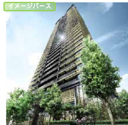
M J R 堺筋本町タワー 新築工事
