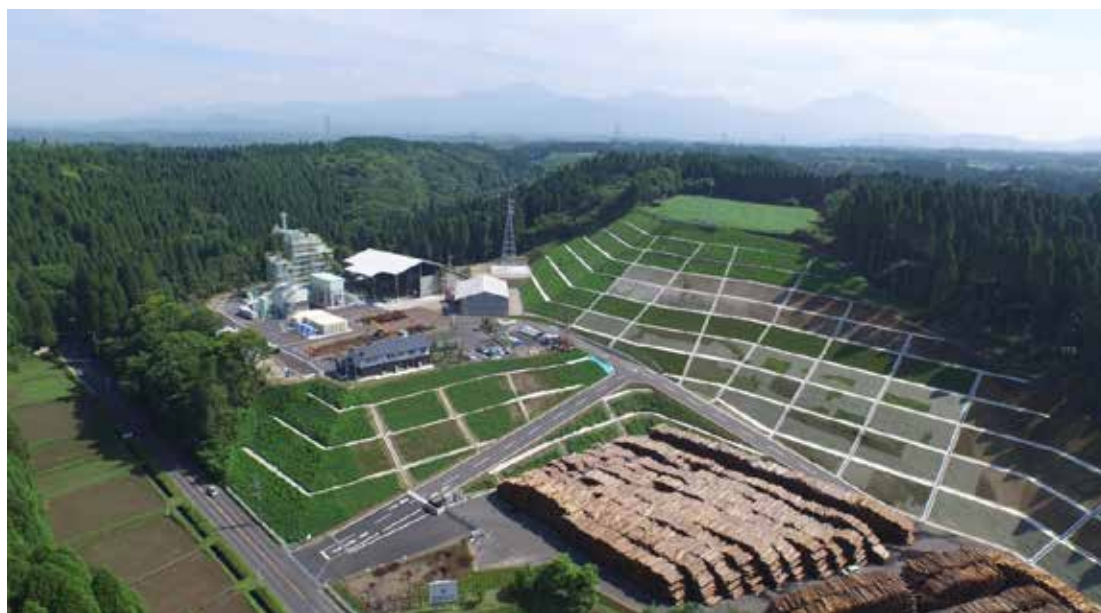
霧島木質発電株式会社の木質バイオマス発電所
