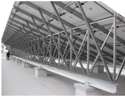
①太陽電池アレイ支持架台
