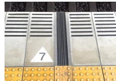
エキスパンションシール （駅のホーム）
