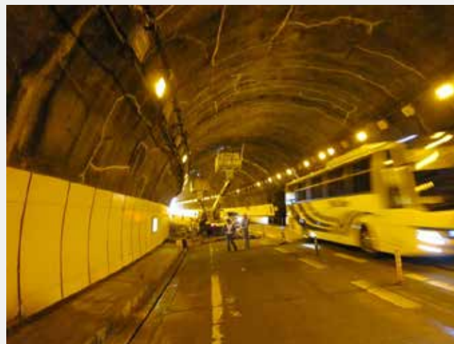
トンネル吹付けモルタル部剥落対策工事 (スケルトンクリアーコーティング)
