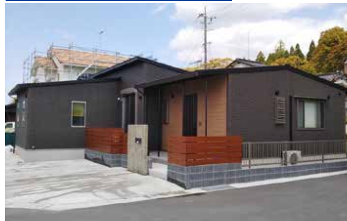
新築工事（戸建住宅）
