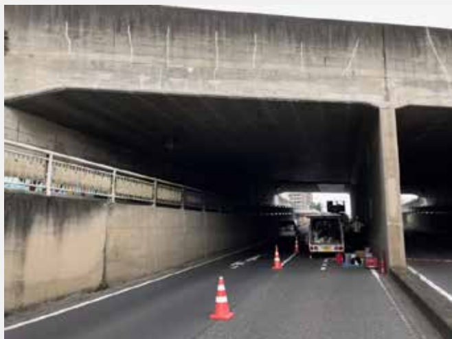
カルバート剥落対策工事 (超薄膜スケルトンはく落防災コーティング)
