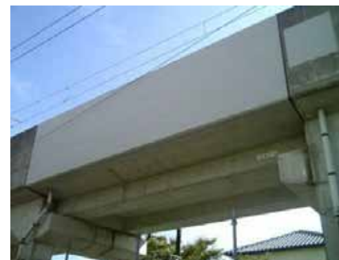
はく落防災コーティング
