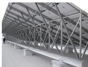
①太陽電池アレイ支持架台
