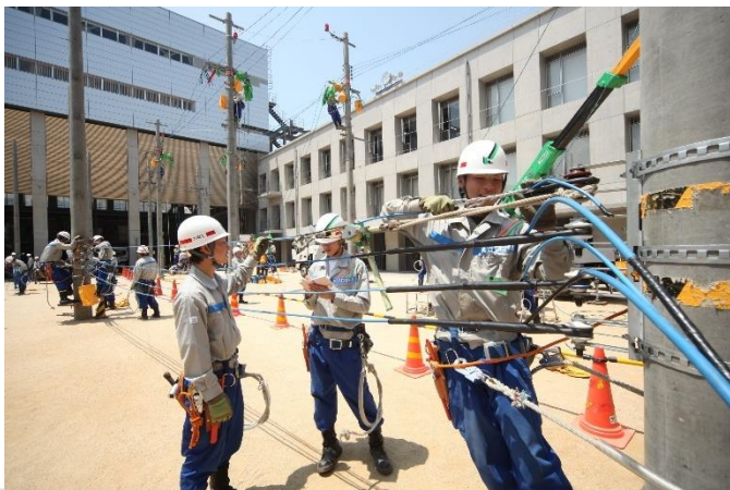
配電昇柱研修
