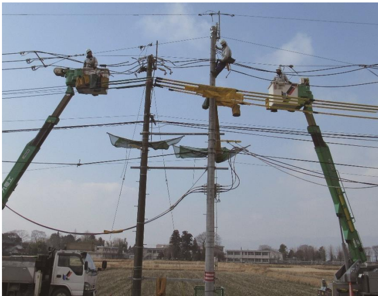
バイパスケーブルを用いた無停電工法
