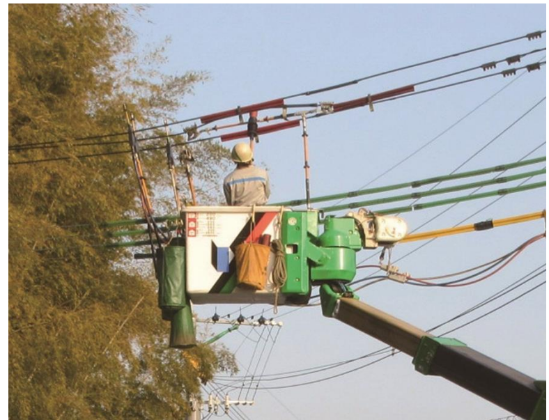
間接活線工法
