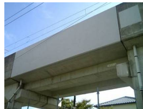
はく落防災コーティング
