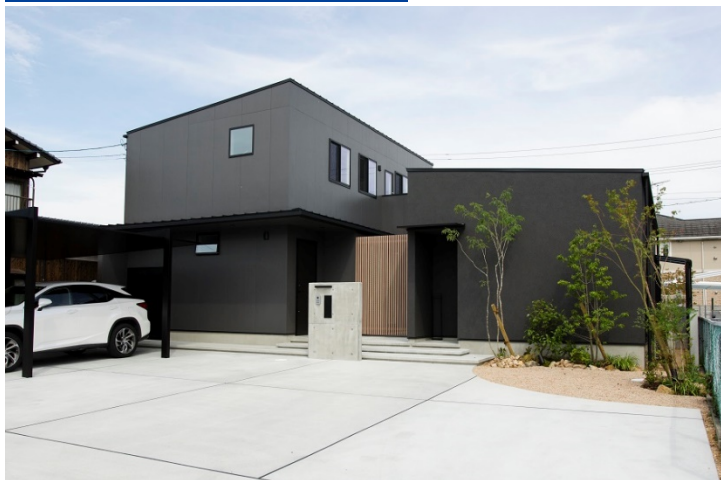
新築工事（戸建て住宅）
