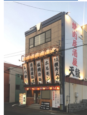
店舗新装工事
