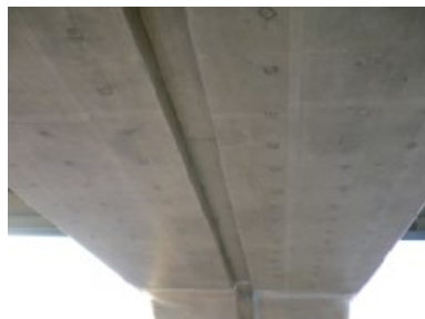
点検箇所撮影
