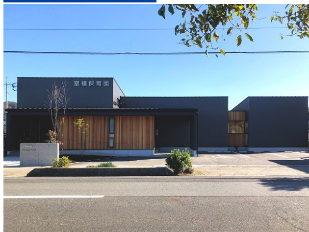
保育園新築工事
