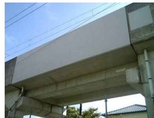
はく落防災コーティング
