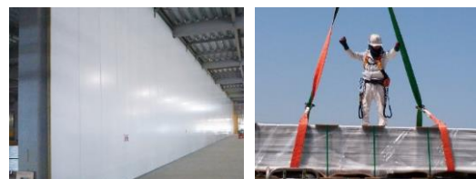
耐火/不燃断熱パネル設置工事
