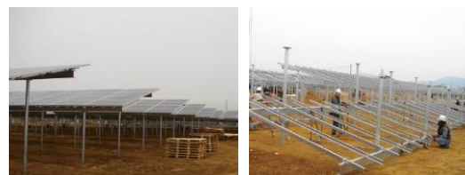
太陽電池アレイ支持架台設置工事
