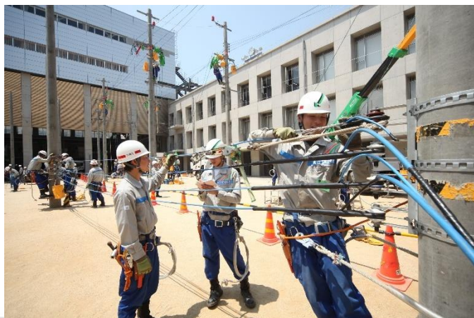
配電昇柱研修
