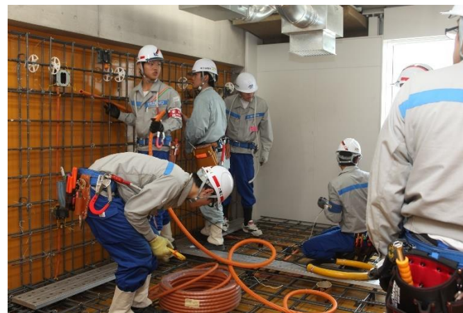
電気配線研修
