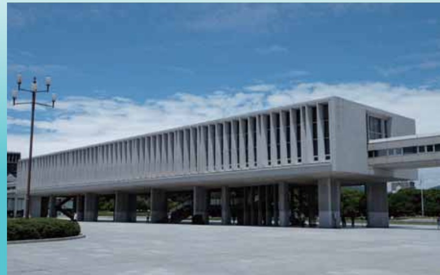
空調機 (AHU) 広島平和記念資料館 (広島市)
