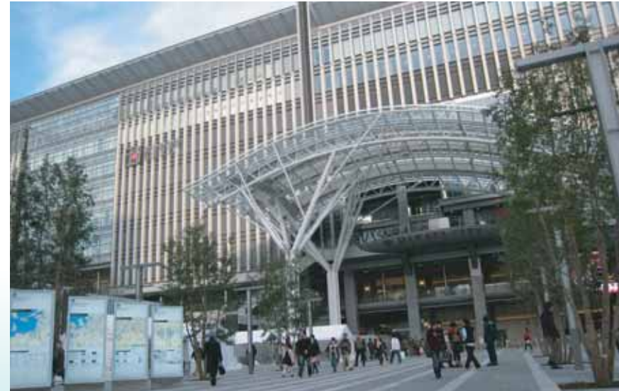
空調機 (AHU) JR博多駅、博多駅デイトス(福岡市)
