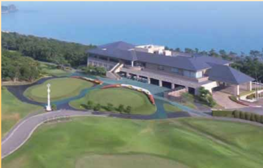
温水ヒーター 芥屋ゴルフ倶楽部(糸島市)
