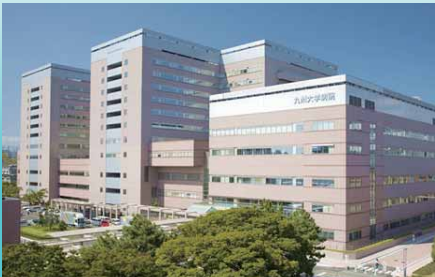
空調機 (FCU) 九大病院(福岡市)
