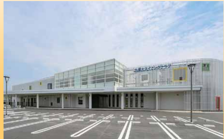
温水ヒーター 九州産業大学屋内プール(福岡市)
