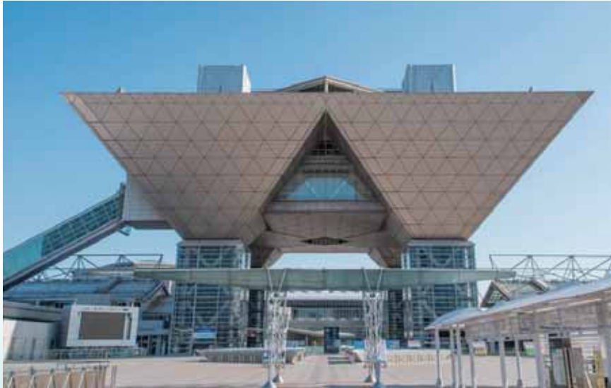
空調機 (FCU) 東京国際展示場 (東京都)
