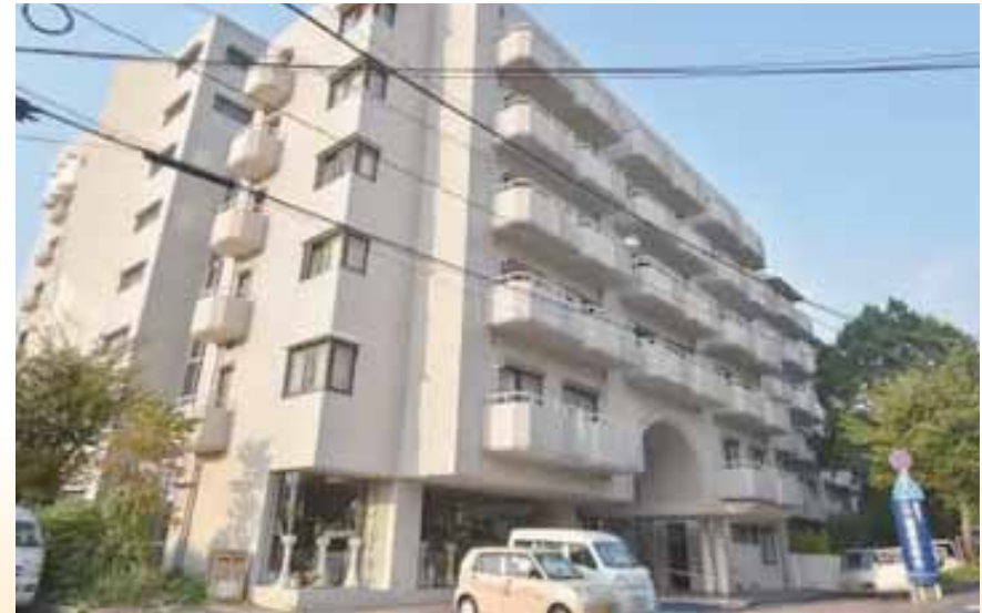
温水ヒーター アビタシオン博多1号館(福岡市)
