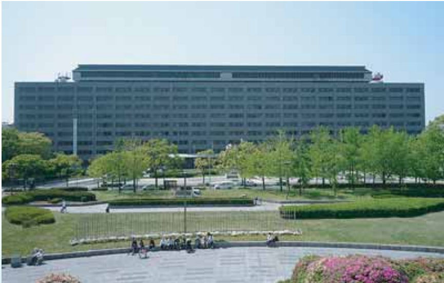
空調機 (AHU) 福岡県庁(福岡市)
