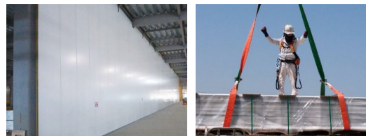
耐火/不燃断熱パネル設置工事
