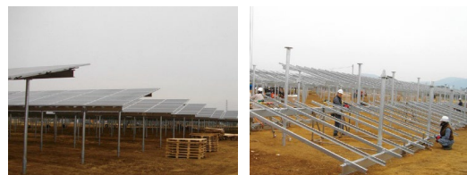
太陽電池アレイ支持架台設置工事
