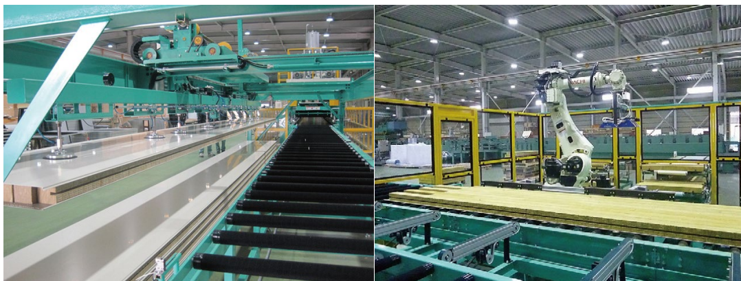
現在福島第1工場稼働中の耐火パネル生産ライン
