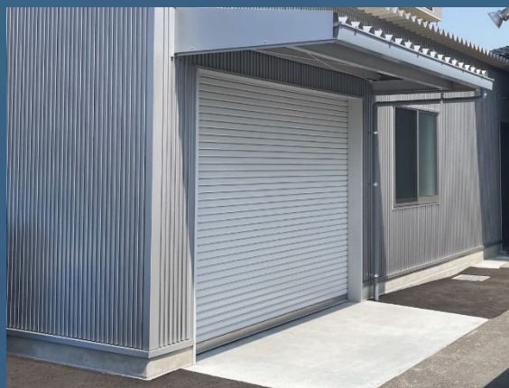
フロアマット工場-外観
