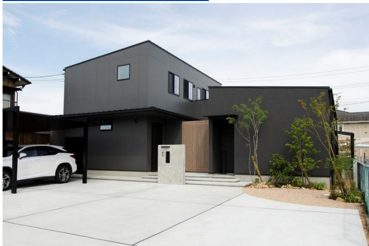
新築工事（戸建て住宅）
