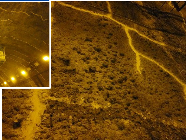
吹付けモルタルトンネル
