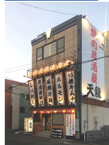
店舗新装工事
