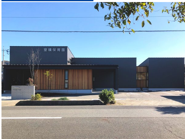
保育園新築工事
