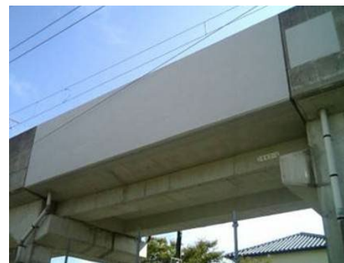
はく落防災コーティング
