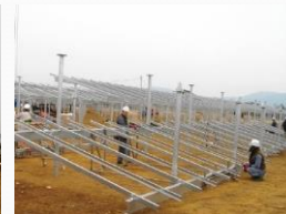
太陽電池アレイ支持架台設置工事
