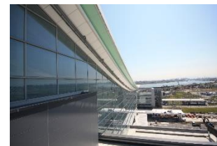
東京国際空港羽田国際線地区 ターミナルビル 大屋根軒天パネル
