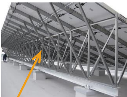
① 太陽電池アレイ支持架台
