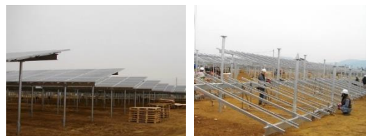
太陽電池アレイ支持架台設置工事
