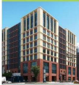
呉服町ビジネスセンター
