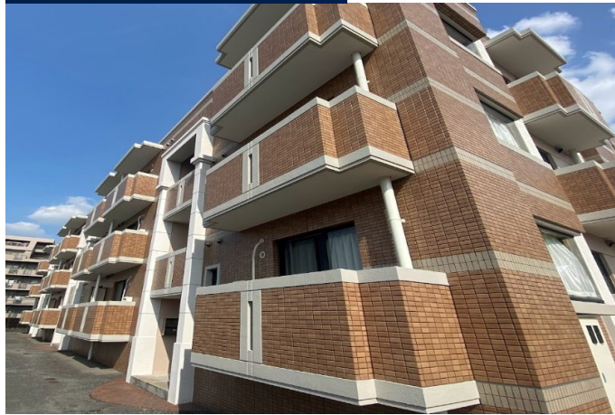
施工後 アパート
