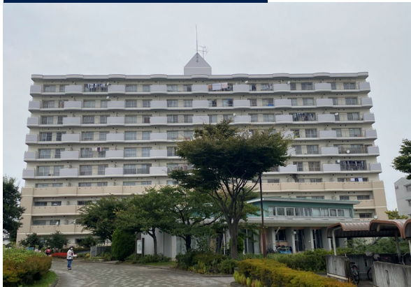
施工後 集合住宅
