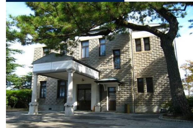
施工後 国有文化財
