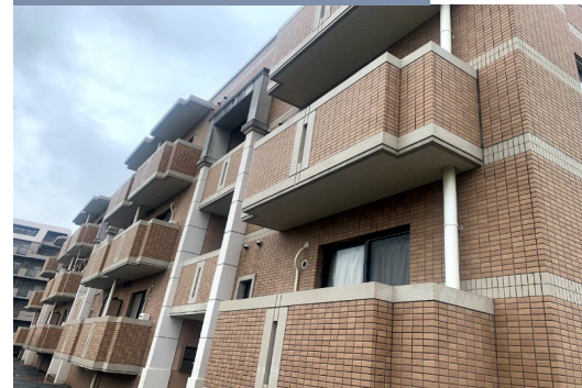
施工前 アパート
