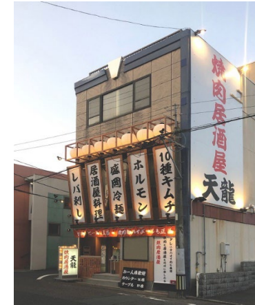
店舗新装工事
