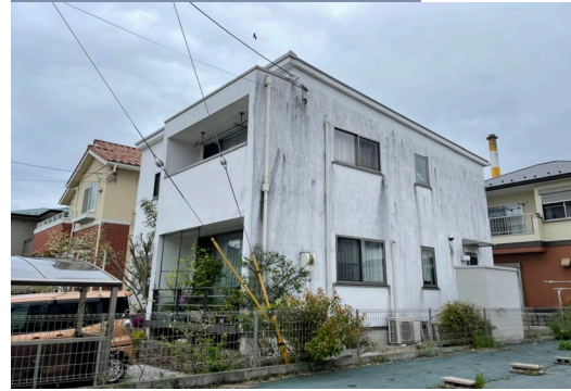
施工前 戸建て住宅
