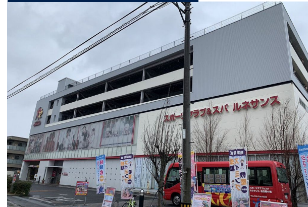
施工後 スポーツクラブ
