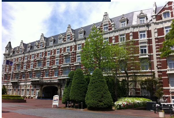
施工後 テーマパーク
