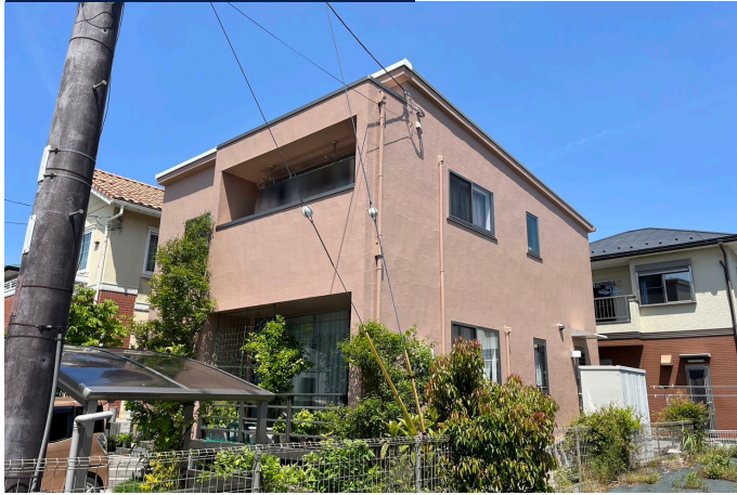
施工後 戸建て住宅
