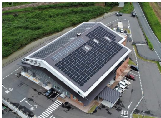
直方市汚泥再生処理センター
