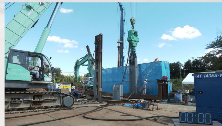
PC矢板の打ち込み状況（試験施工）
