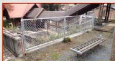
転落防止用のフェンスを設置
