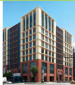
呉服町ビジネスセンター
