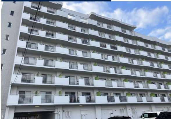
施工後 集合住宅
