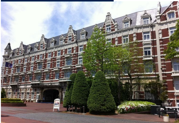
施工後 テーマパーク
