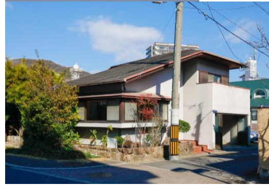
施工前 戸建て住宅
