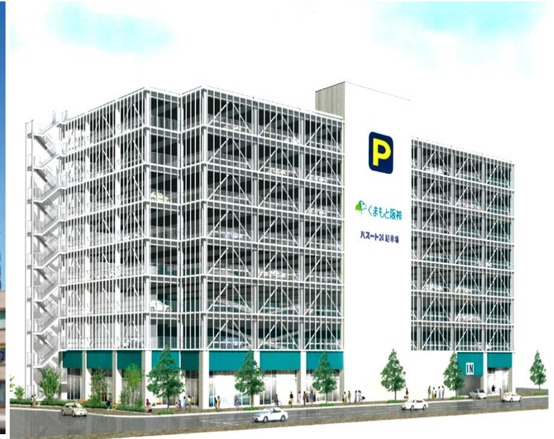
立体駐車場(熊本県)
