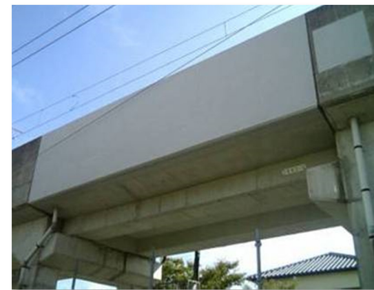
はく落防災コーティング
