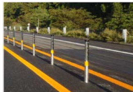
※写真は中央帯1.5mを確保して設置している事例
