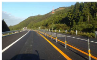
(磐越道 三川IC～安田IC) 延長0.4km
