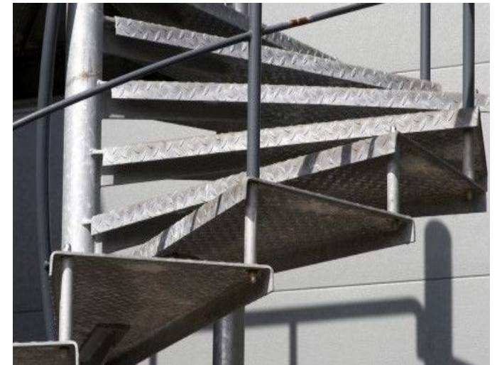
縞鋼板を階段に加工したもの
