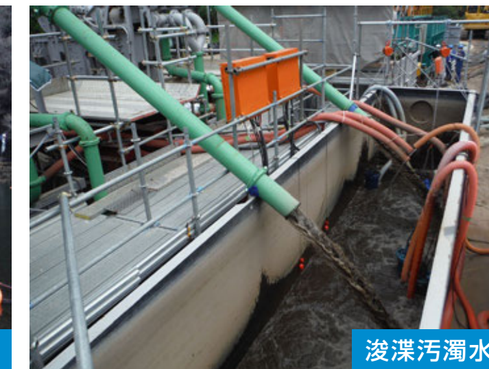
ダム湖での浚渫工
