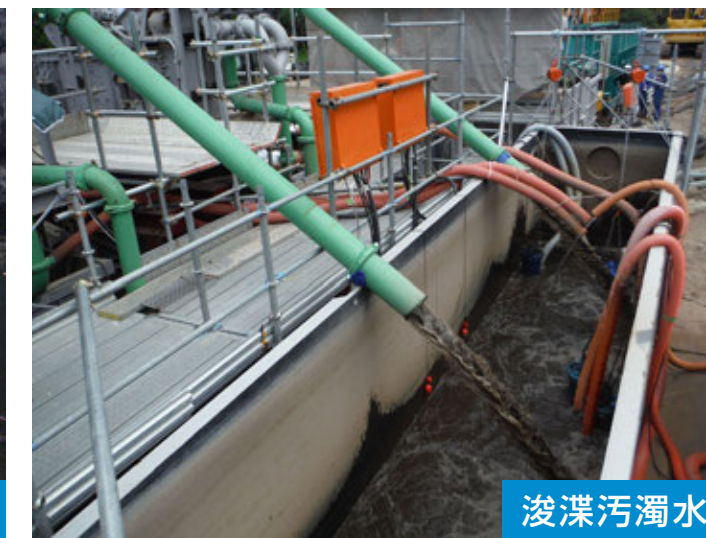
ダム湖での浚渫工
