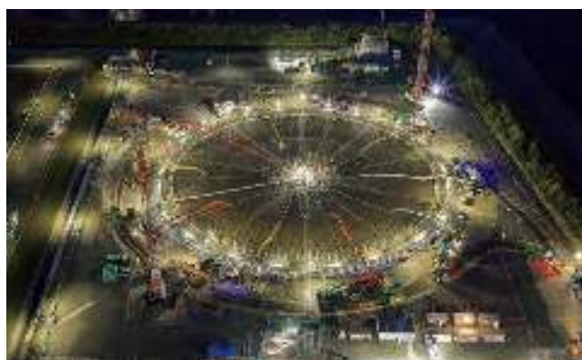
ひびきLNG基地3号タンク増設工事の様子 タンク底部のコンクリート一括打設(2026年4月時点)
