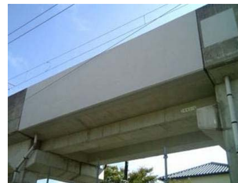
はく落防災コーティング
