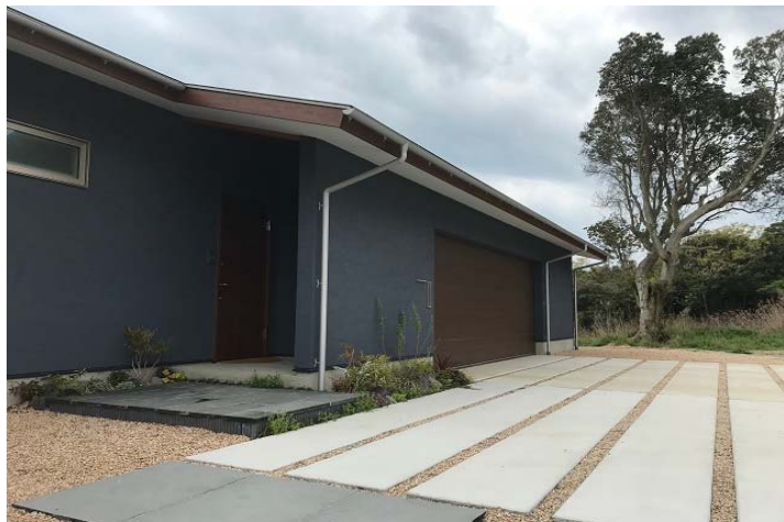
戸建て新築工事
