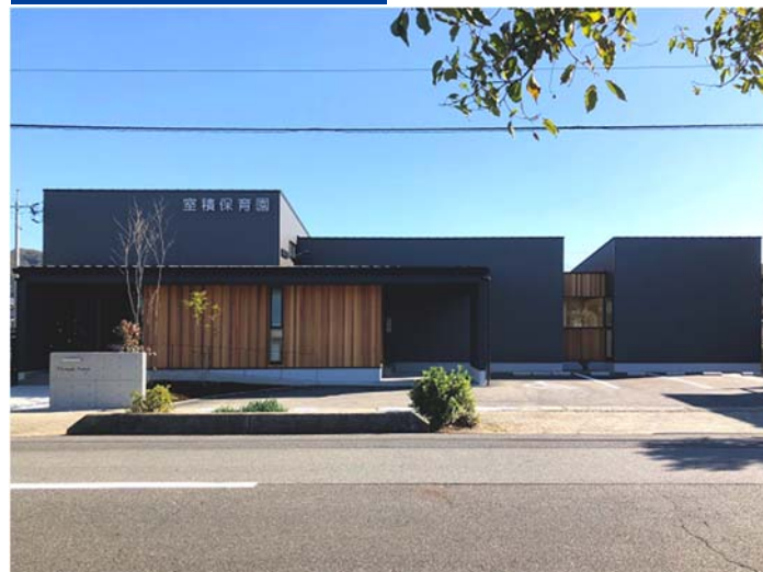
保育園新築工事
