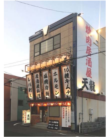
店舗新装工事
