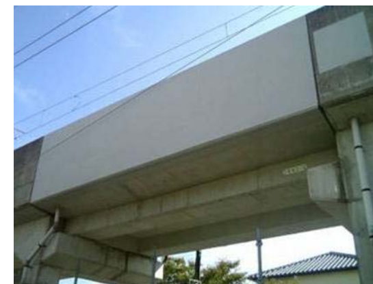
はく落防災コーティング
