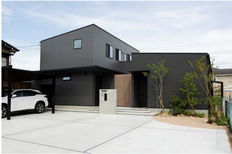
新築工事（戸建て住宅）
