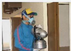
害虫防除施工
